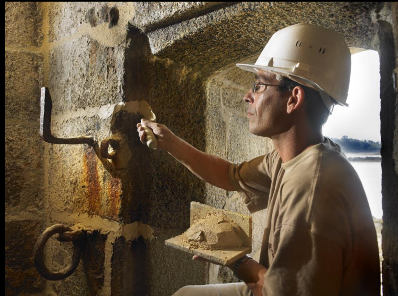
Le Maçon (Christophe Schwickert - Sté Lefevre) Château du Taureau Baie de Morlaix 6 Sept. - 15 h 37
